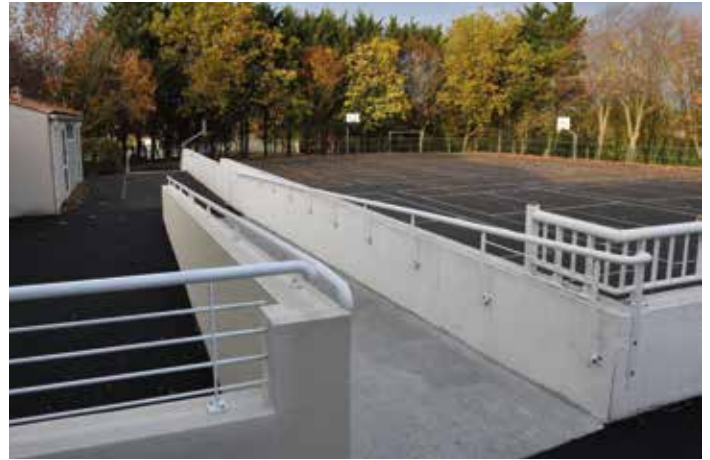
Ecole A. Devaud : mise en place d'une rampe d'accès.
