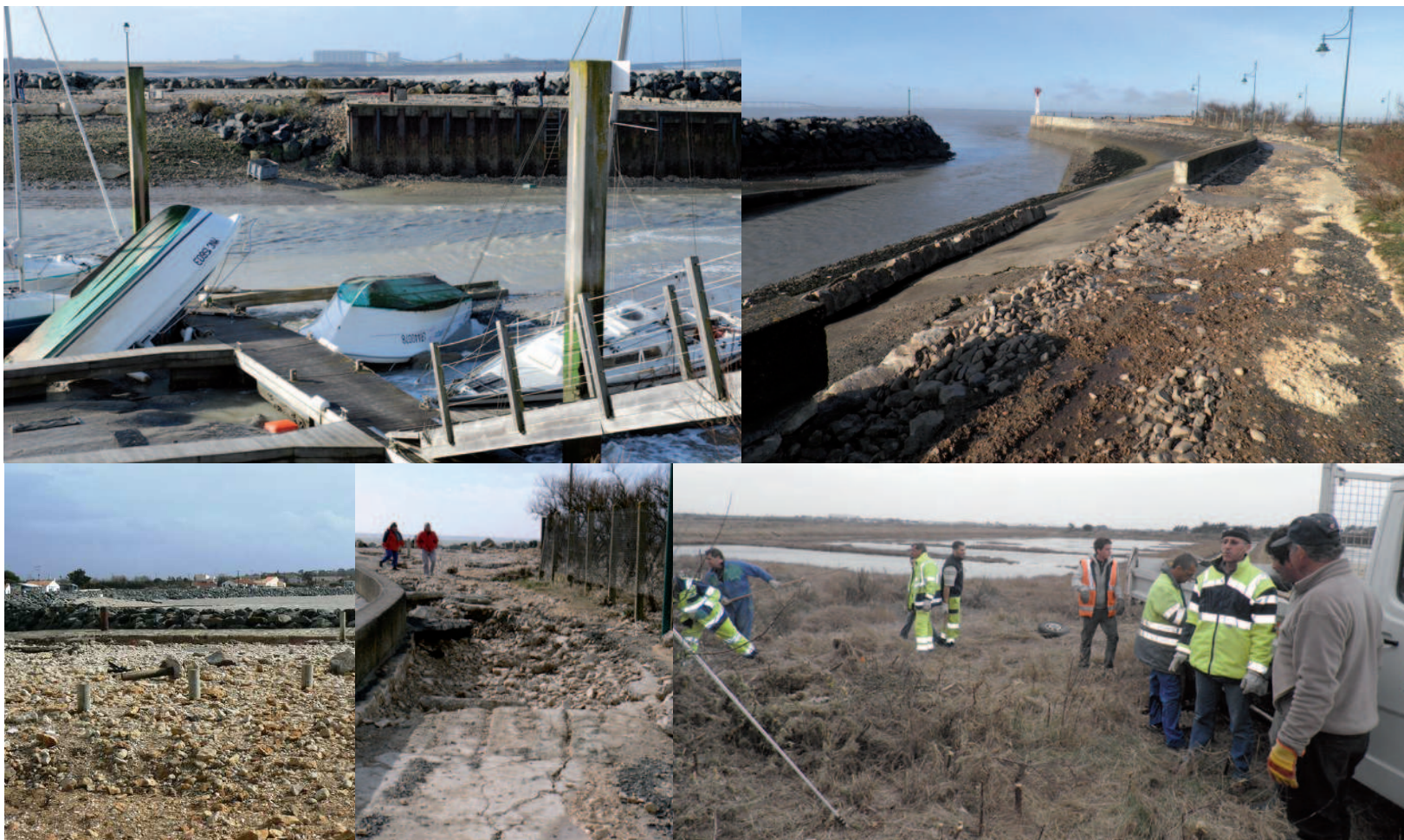
Le chemin côtier a disparu sous l'enrochement que l'océan a déplacé.
