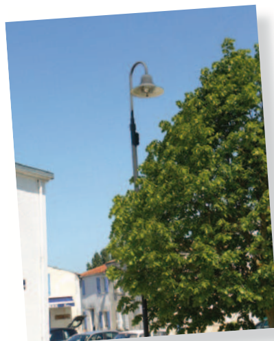
La modernisation du réseau d'éclairage public permettra la réalisation d'économies d'énergie
