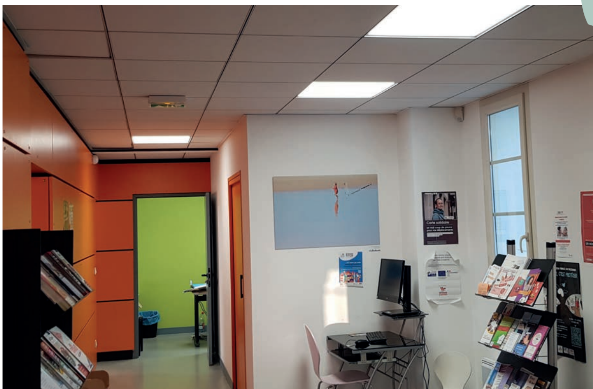
Le plafond à led du CCAS
