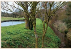
Digue de la station de lagunage
