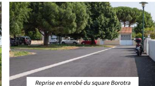
Reprise en enrobé du square Borotra
