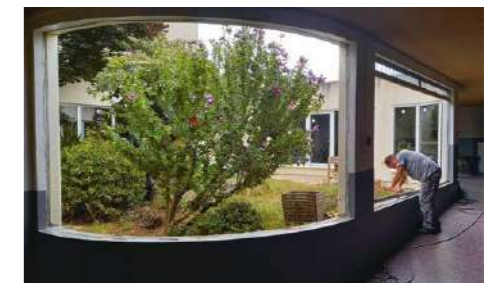
Changement de la verrière centrale à l'école Alain Devaud
