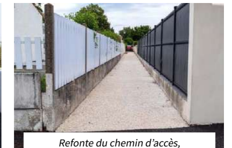
Refonte du chemin d'accès, en béton lavé, entre square Borotra et rue des Tourettes
