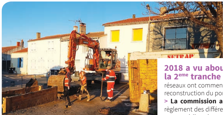
• 2018 et 2019 : deux années marquées par d'imposants travaux à Lauzières.
