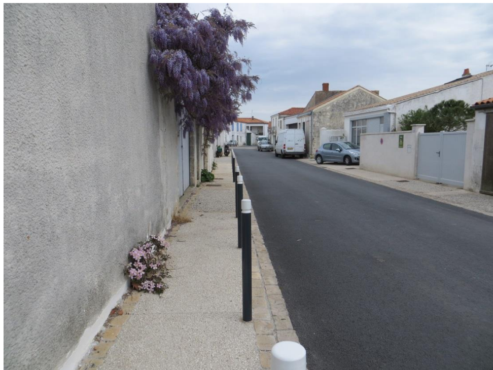
Vue des travaux de la tranche 1
