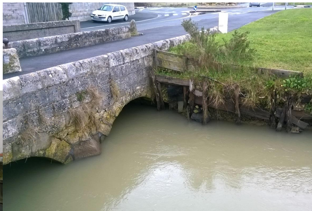
Vue aval du vieux pont de Lauzières
